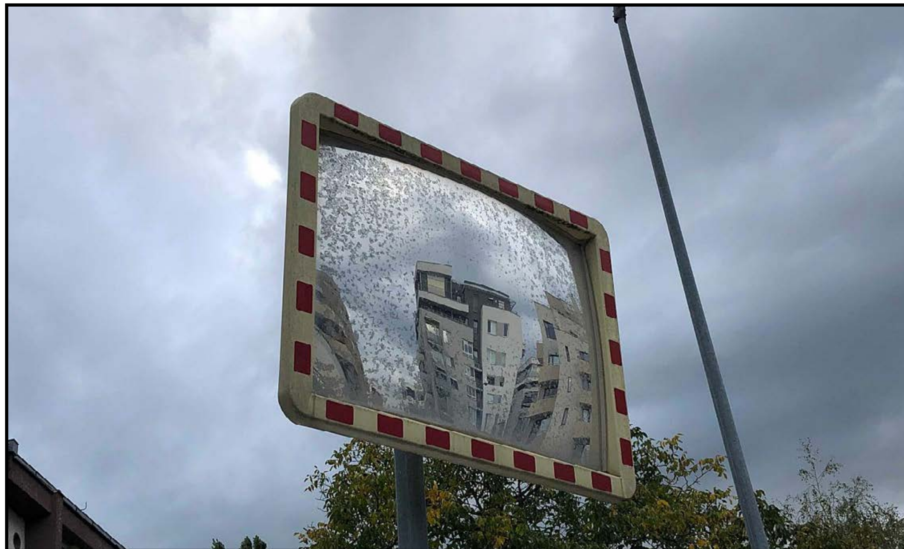
Poškozené dopravné zrkadlo
